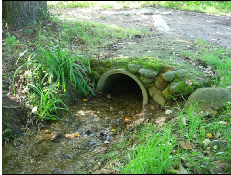
Figura 4-20 Rio di Nebbiana RS 135 (vista verso valle) ingresso nella tubazione \Phi 50 .
