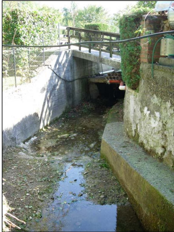
Figura 4-17 Rio Zanesi - attraversamento RS 75 (vista verso valle)
