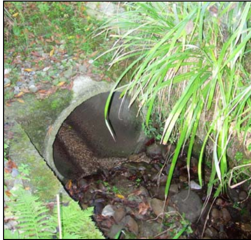
Figura 4-23 Rio delle Romite RS 25 (vista verso valle) ingresso tubazione \Phi 80
