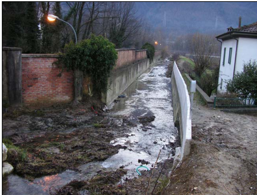
Figura 4-6 Rio della Giuvicchia RS 61 (vista verso valle); in dx idraulica è possibile osservare l’immissione del Rio Catarozzo.
