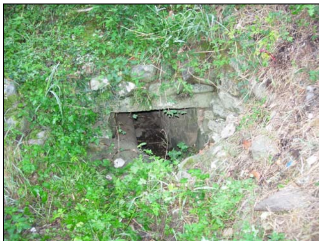
Figura 5-6 Solco di Santa Maria - RS 55 (vista verso valle) Ingresso nello scatolare di dimensioni 0.8 \times 0.45 m
