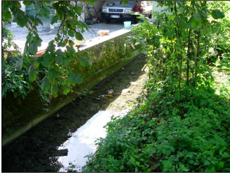
Figura 5-1 Rio Fontana Maggio RS 40 (vista verso valle) è possibile notare il muro di sponda in sinistra idraulica
