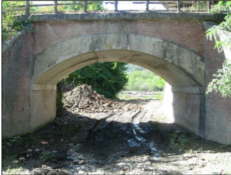
Figura 4-4 Rio Fontana Maggio RS 04 Ponte FF.SS. RS 25 (vista verso valle)
