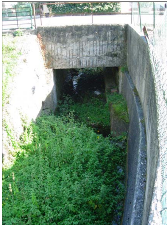
Figura 4-18 Rio Zanesi - attraversamento della via Provinciale RS 105 (vista verso valle)
