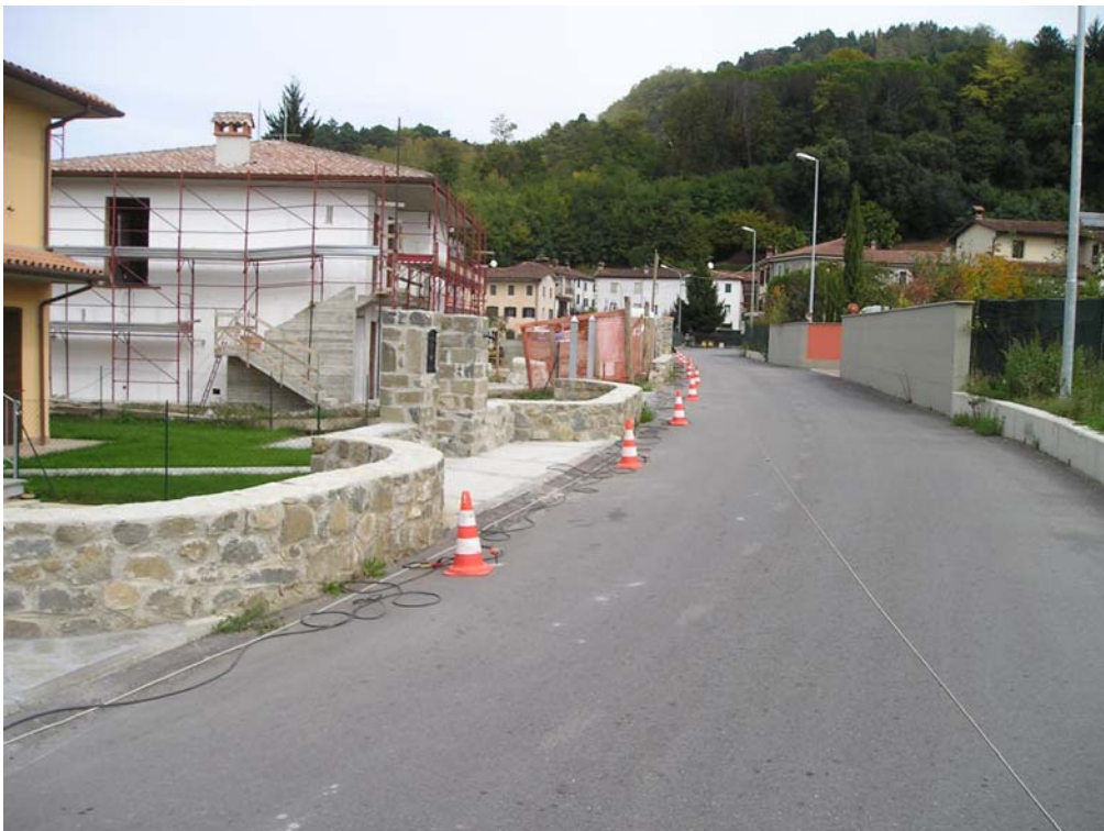
Profilo ST4: stendimento onde SH vista verso G1
