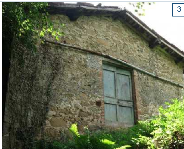
3 - Copertura a capanna, con tavolato a vista nel sottogronda 4- Copertura con utilizzo di capriate
