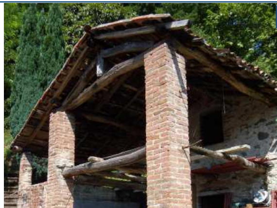
3 - Copertura a capanna, con tavolato a vista nel sottogronda 4- Copertura con utilizzo di capriate
