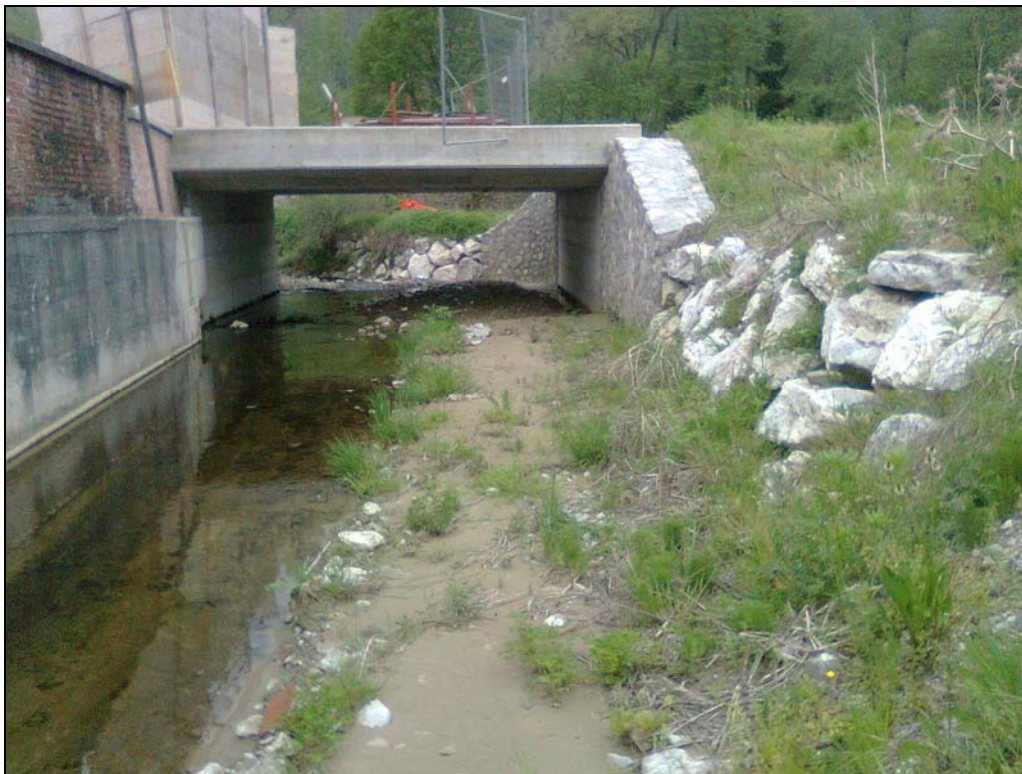
Figura 8 Vista verso valle del nuovo attraversamento alla RS29
