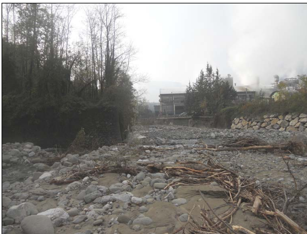
TRATTO 1 vista verso valle del restringimento di sezione che delimita a sud il tratto. In destra sono visibili le scogliere di protezione spondale.
