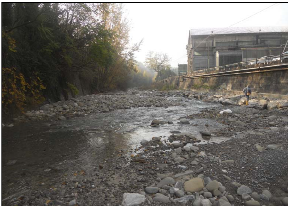
Panoramica del TRATTO 2 vista verso valle. Si vedono i muri sia in destra che in sinistra che confinano il corso d'acqua.
