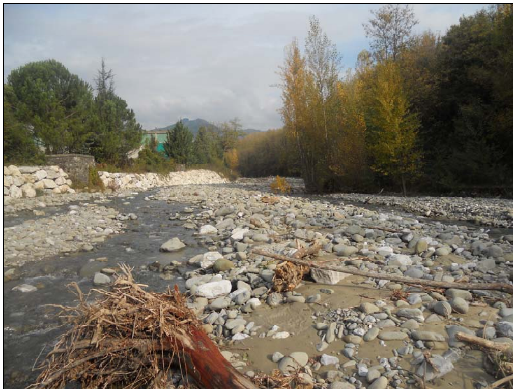
Panoramica del TRATTO 3 vista verso monte. Si vedono i tratti di scogliera in destra e uno degli speroni ancora in destra
