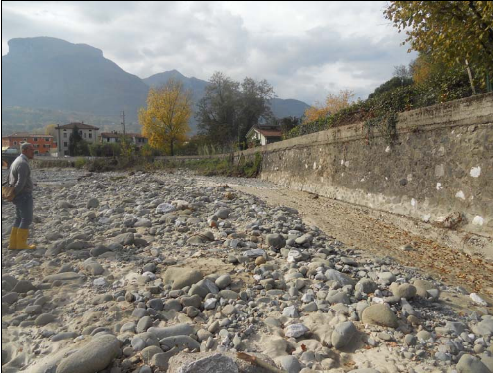
TRATTO 3 vista verso valle. Si vede il muro di sponda in destra idraulica e i successivi interventi di sottofondazione e rialzo. In lontananza il ponte sulla SR 445.
