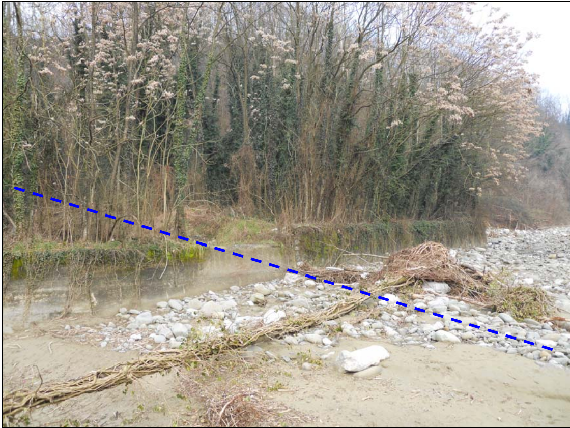
Vista del muro d'argine con traccia della sez 6. Al centro della foto è visibile lo scalino nel muro. (vista verso monte).
