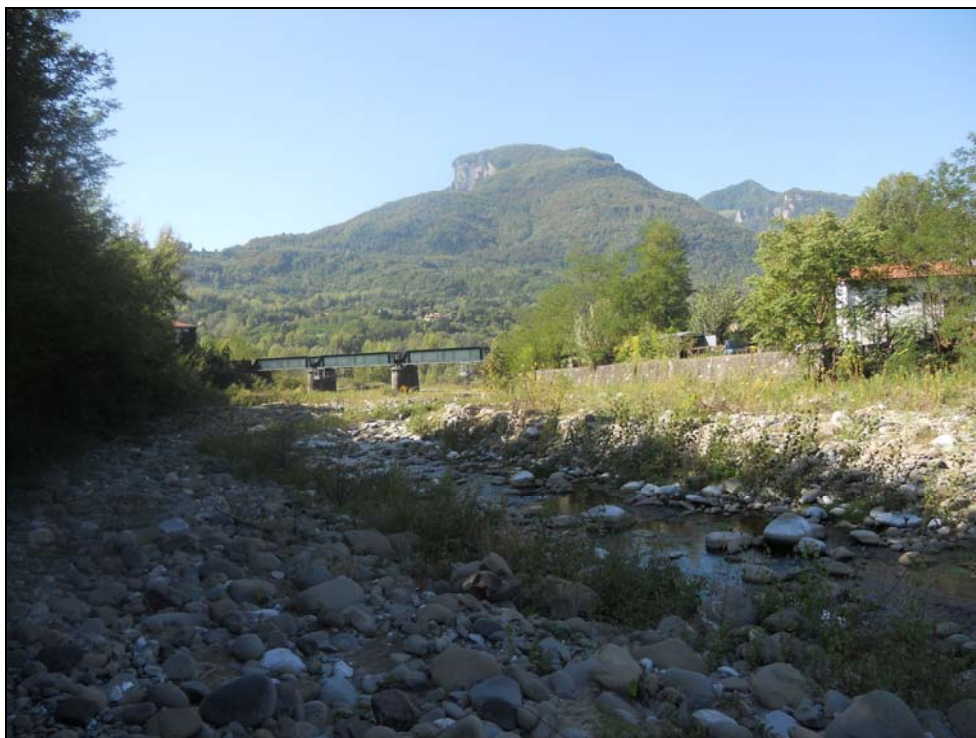
Panoramica del TRATTO 4 vista verso valle. In lontananza il ponte della linea ferroviaria.
