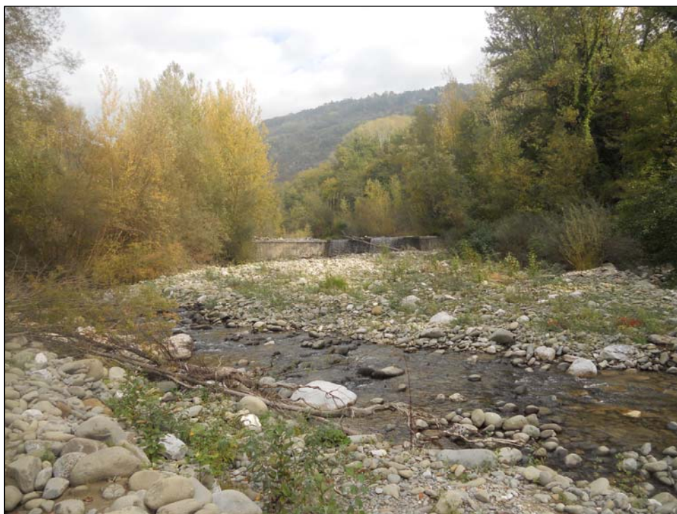
Panoramica del TRATTO 1 vista verso monte. In lontananza si intravede la briglia che delimita il tratto a nord.
